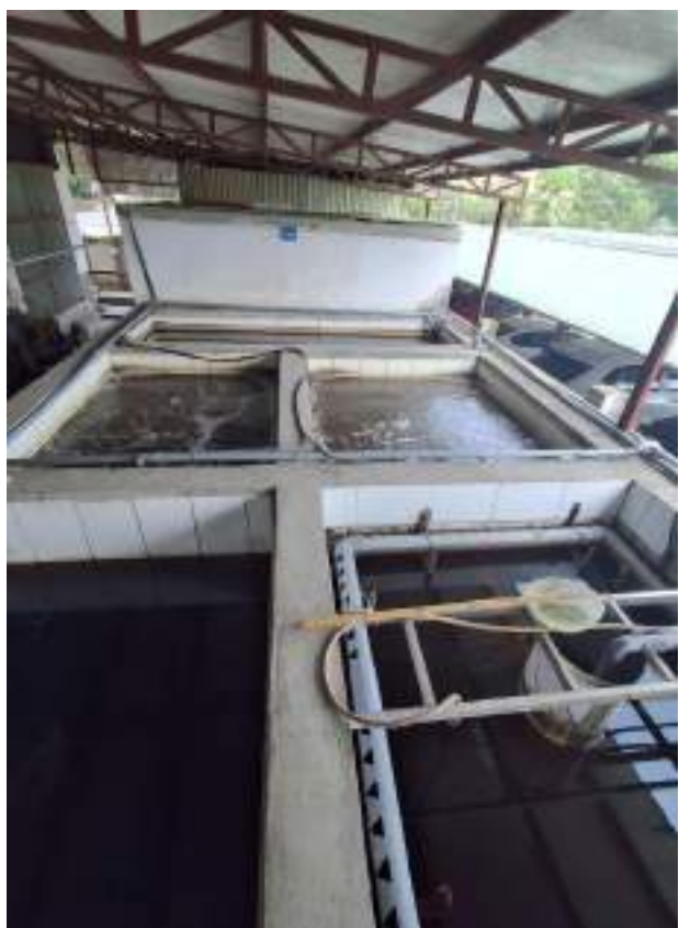
Hình 3. 8. Một số hình ảnh của hệ thống xử lý nước thải sinh hoạt công suất 30m 3 /ngày đêm
